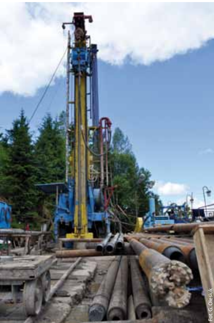
Badawczy otwór hydrogeologiczny w trakcie wiercenia (2010), Udryń, NE Polska
