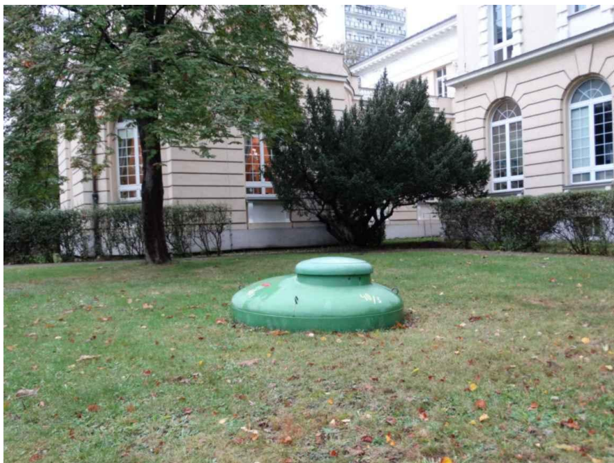
Fot. 3. Obiekt hydrogeologiczny nr 5241004 należący do ujęcia nr 5240486.
