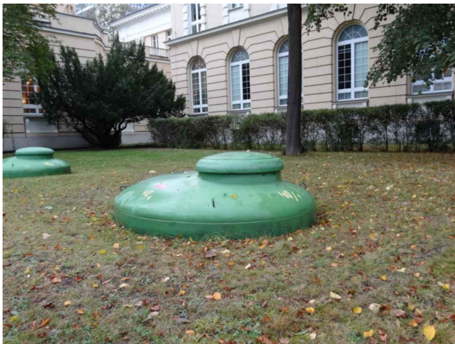
Fot. 5. Obiekt hydrogeologiczny nr 5241007 należący do ujęcia nr 5240486.
