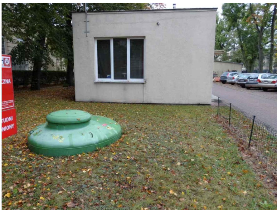
Fot. 4. Obiekt hydrogeologiczny nr 5240265 należący do ujęcia nr 5240486.
