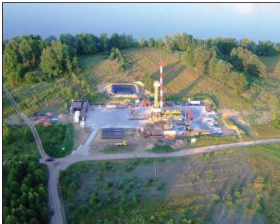
Widok wiertni w trakcie wykonywania ujęć wód leczniczych w Goldapi (fot. Archiwum PWiK w Goldapi)
