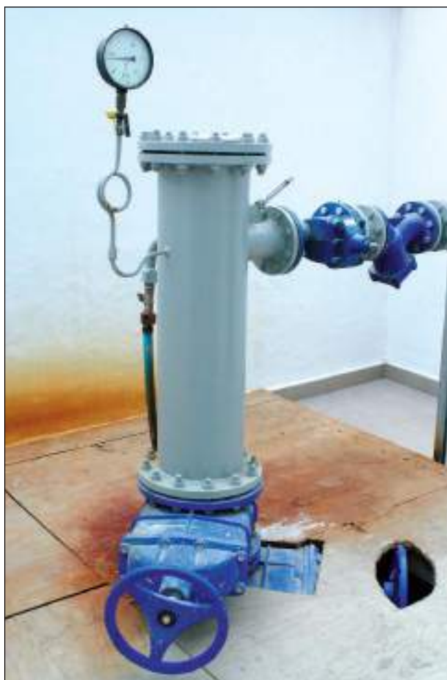
Głowica ujęcia termalnych wód wodorowęglanowych Zakopane IG-1 (fot. J.Sokołowski)
