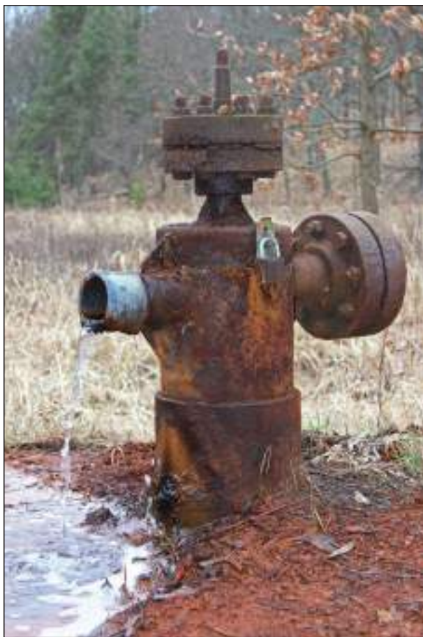
Niezagospodarowane ujęcie wód termalnych Frombork IG-1 (fot. J. Sokółowski)
