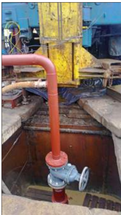
Głowica ujęcia termalnych wód siarczkowych w Cudzynowicach w trakcie trwania robót geologicznych (fot. B. Wiktorowicz)
