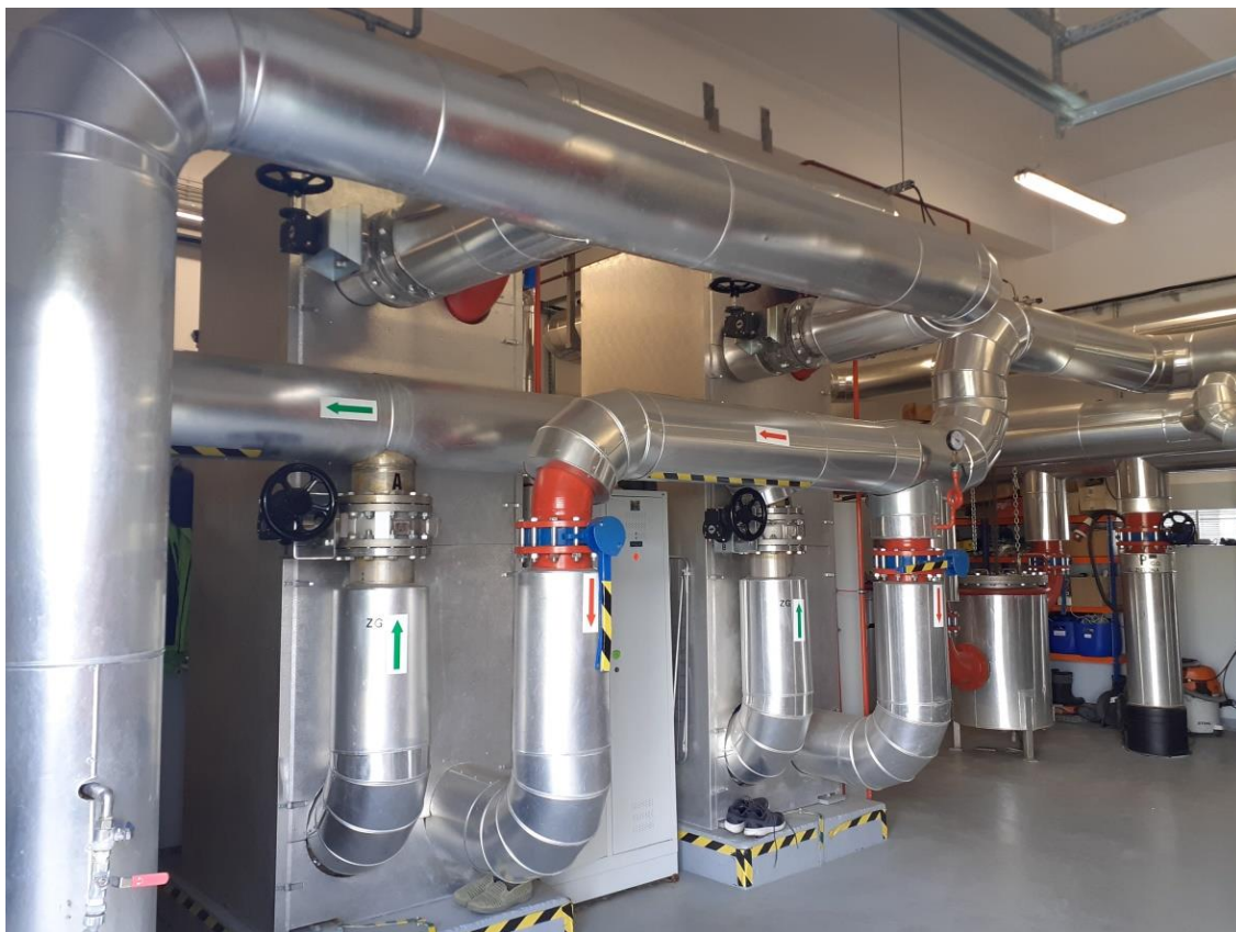
Fot. 5.3. Wymiennikownia ciepła w ciepłowni geotermalnej Poddebice ( fot. Archiwum Geotermii Poddebice Sp. z o.o. )
