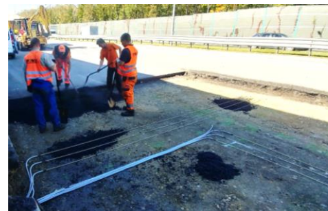
Instalacja światłowodowych czujników odkształceń w warstwach asfaltowych oraz przykładowe wyniki pomiarów z czasu
