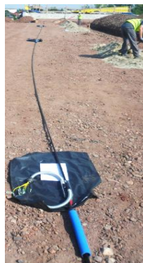
Instalacja światłowodowych czujników przemieszczeń oraz inklinometru poziomego wewnątrz nasypu drogowego za przyczółkiem obiektu mostowego
