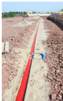
Instalacja światłowodowych czujników przemieszczeń oraz inklinometru poziomego wewnątrz nasypu drogowego za przyczółkiem obiektu mostowego
