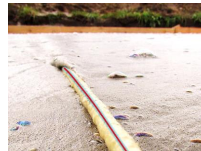
Instalacja światłowodowych czujników odkształceń w warstwach podbudowy z pianobetonu oraz widok konstrukcji drogi z czasu obciążeń próbnych
