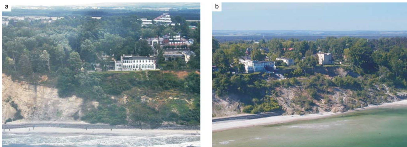
Rys. 10.28. Widok klifu w rejonie km 133.710
