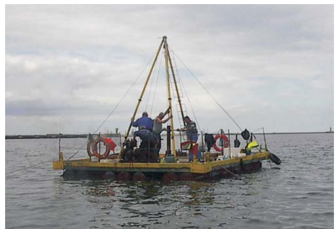
Fig. 7.33. Platforma wiertnicza WW-UNIGEO podczas prac geologiczno-inżynierskich pod budowę Głębokowodnego Terminalu Kontenerowego DCT w Gdańsku
