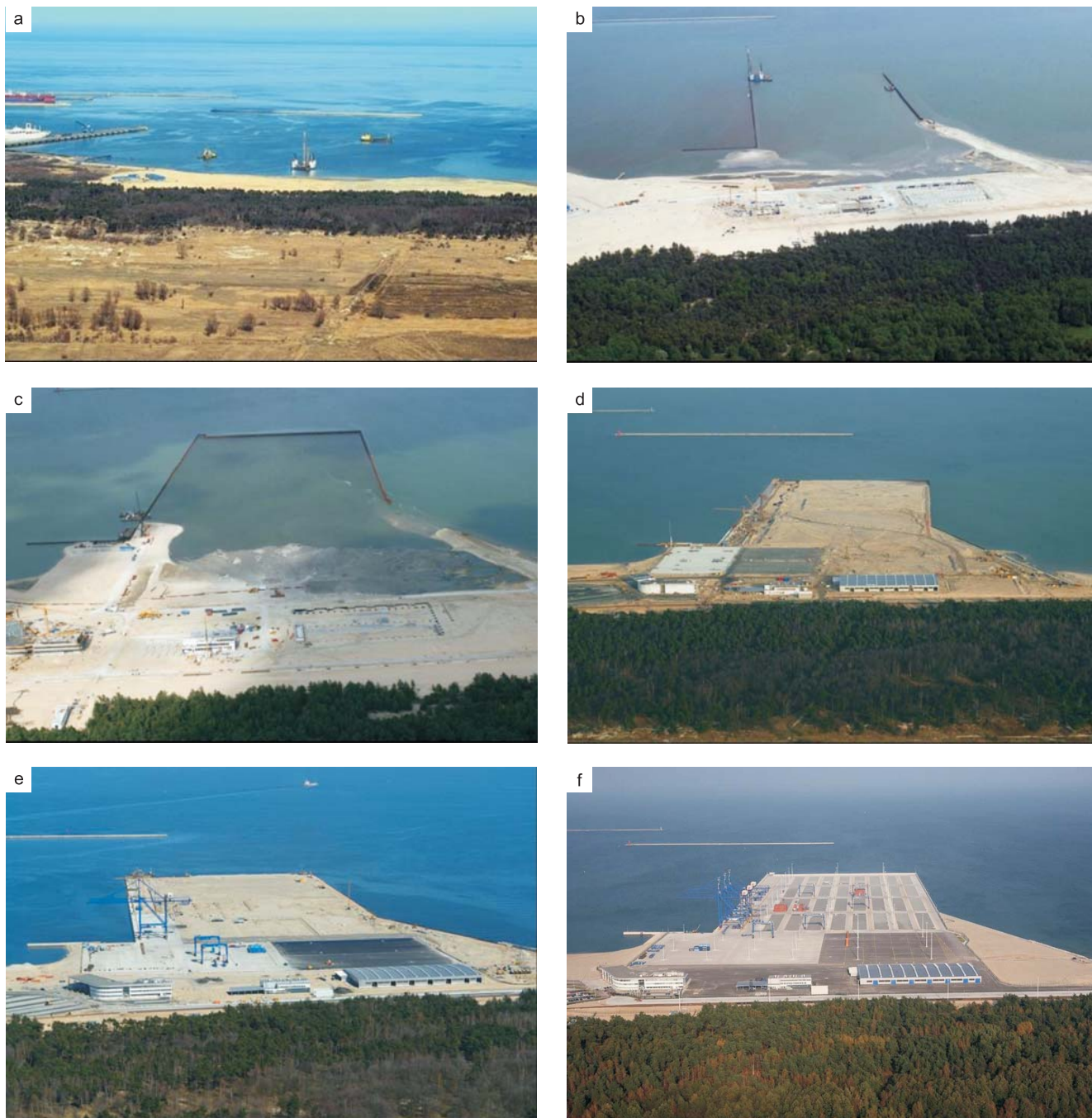
Rys. 10.24. Widok kolejnych etapów budowy pirsu
