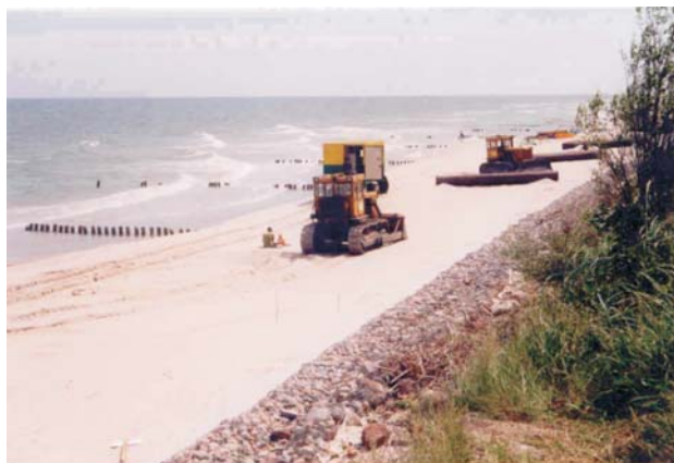
Rys. 5.13. Odbudowa zniszczonego brzegu poprzez sztuczne zasilanie piaskiem
