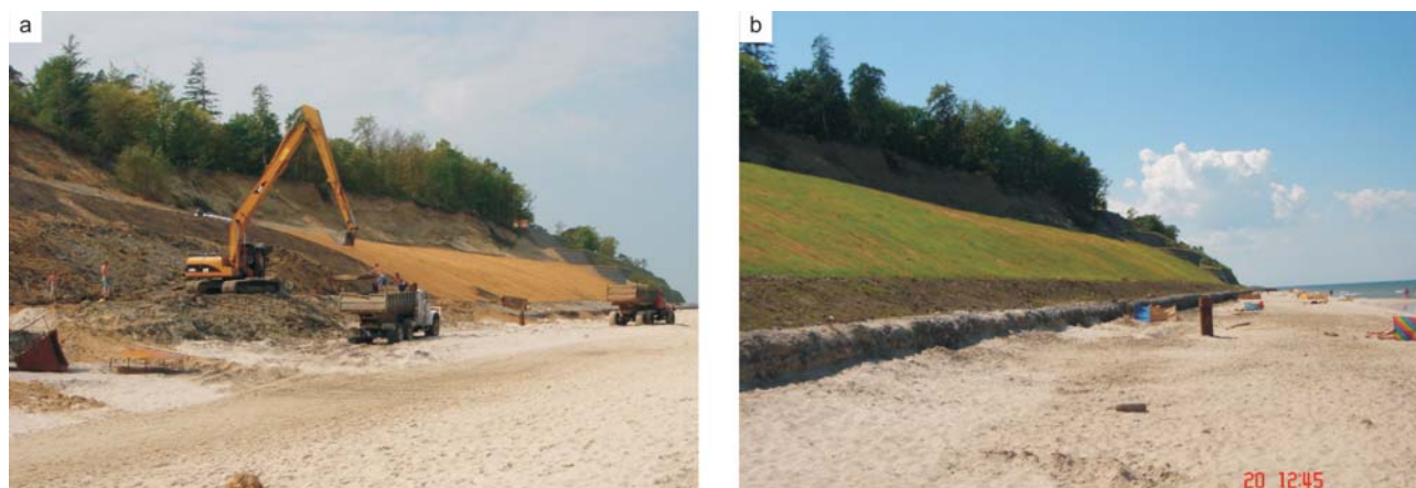
Rys. 10.34. Zabezpieczenie zbocza klifu na odcinku leśnym
