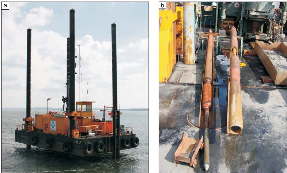
Fig. 7.32. Geotechniczna platforma samopodnosząca MH 2 podczas prac geologiczno-inżynierskich w Świnoujściu: a – widok ogólny, b – dynamiczna sonda otworowa BDP oraz rdzeniówka otworowa na pokładzie platformy
