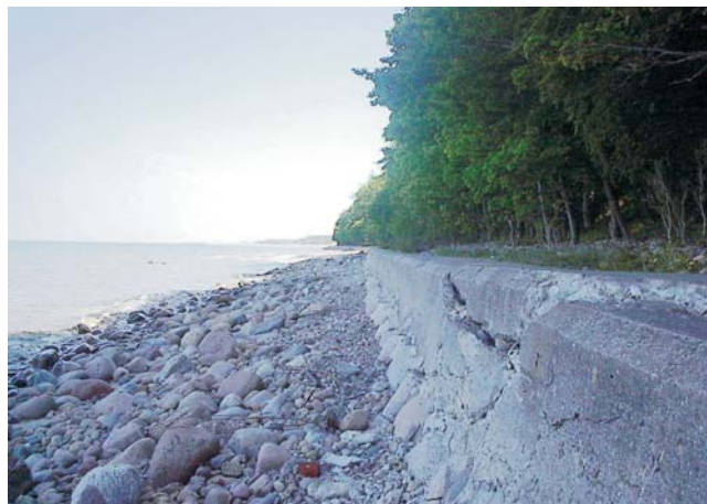
Rys. 10.40. Betonowa opaska brzegowa w Rozewiu
