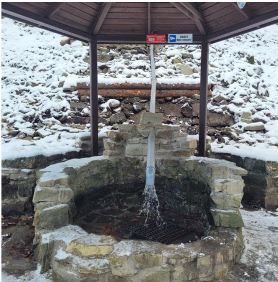
Ryc. 10.4. Punkt obserwacyjny II/1656/1 Szyndzielnia (woj. śląskie) po wykonaniu remontu obudowy źródła.
