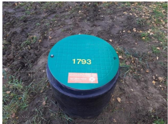
Ryc. 10.3. Obudowa otworu z samowypływem II/1793 Koźminek (woj. wielkopolskie) po wymianie głowiczki ciśnieniowej i obudowy otworu.
