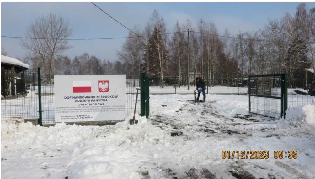
Ryc. 10.9. Ogrodzenie terenu stacji hydrogeologicznej II/1645 Chełm Śląski (woj. śląskie).
