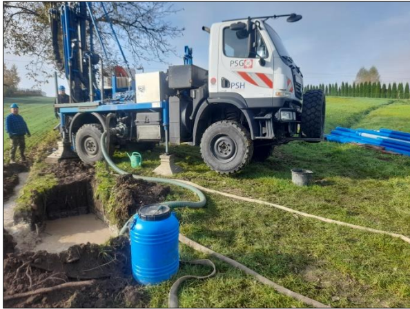
Ryc. 12.5. Wiercenie na stoku w m. Maciejowice, gm. Kocmyrzów-Luborzyca (październik 2023). System wiercenia - obrotowo na płuczkę. Głębokość wiercenia 51,0 m.
