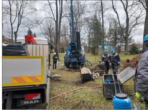
Ryc. 12.2. Prace przygotowawcze w m. Brańszczyk, gm. Brańszczyk (marzec 2023 r.). System wiercenia – obrotowo na płuczkę. Głębokość wiercenia 50,0 m.
