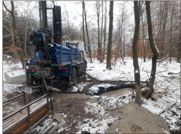
Ryc. 12.6. Wiercenie otworu w m. Porządzie, gm. Rząśnik (listopad 2023). System wiercenia – obrotowo na płuczkę. Głębokość wiercenia 40,0 m.
