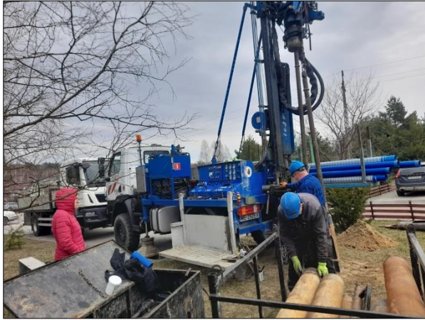
Ryc. 12.1. Wiercenie otworu w Rusinów, gm. Borkowice (marzec 2023 r.). System wiercenia – udarowy. Głębokość wiercenia 9,0 m.
