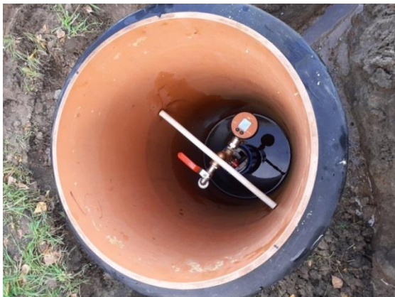
Ryc. 10.3. Obudowa otworu z samowypływem II/1793 Koźminek (woj. wielkopolskie) po wymianie głowiczki ciśnieniowej i obudowy otworu.
