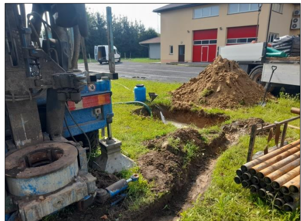
Ryc. 12.4. Przygotowanie dołu płuczkowego w m. Zarzeczce, gm. Zarzeczce (lipiec 2023 r.). System wiercenia – obrotowo na płuczkę. Głębokość wiercenia 16,0 m.
