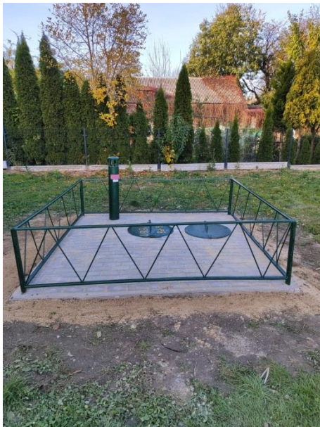
Ryc.10.7. Zabezpieczenie otworów obserwacyjnych II/1518/1 (woj. lubelskie) i II/849/1 Słupiec (woj. małopolskie).
