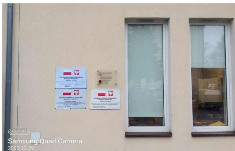
Ryc. 22.3. Budynek serwerowni PIG-PIB.
