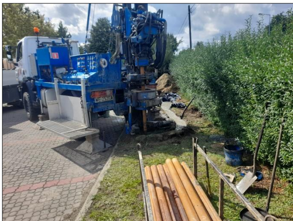
Ryc. 12.3. Wiercenie otworu w Cmolas, gm. Cmolas (sierpień 2023 r.). System wiercenia – obrotowo na płuczkę. Głębokość wiercenia 37,0 m.
