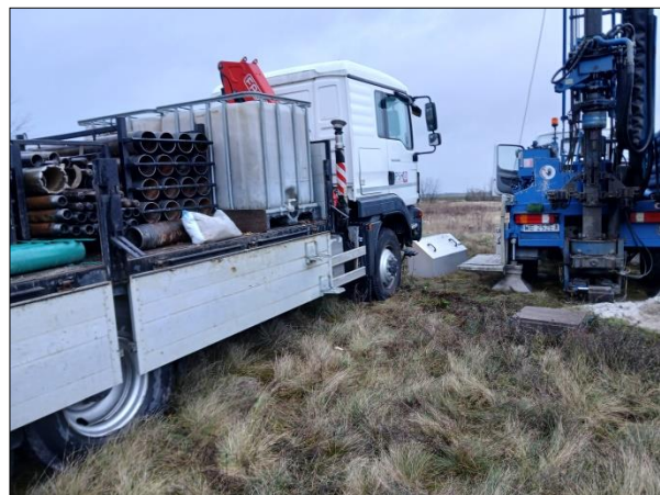
Ryc. 12.6. Wiercenie czterech otworów w Zasiękach, gm. Brody (listopad 2024). Głębokość wiercenia od 9,6 do 27,5 m.
