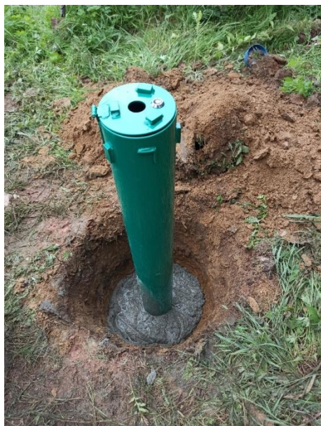
Ryc. 10.2. Punkt obserwacyjny II/1938/1 Łączna (woj. dolnośląskie) w trakcie prac związanych z wymianą obudowy piezometrycznej.
