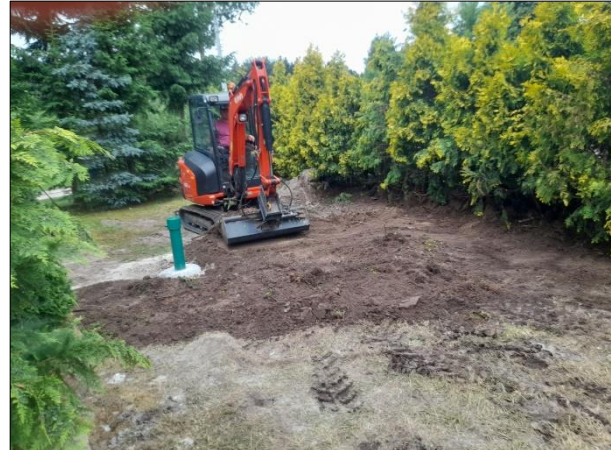
Ryc. 12.4. Prace porządkowe w m. Podgajek Zachodni, gm. Przytyk (czerwiec 2024 r.). Głębokość wiercenia 51,0 m.
