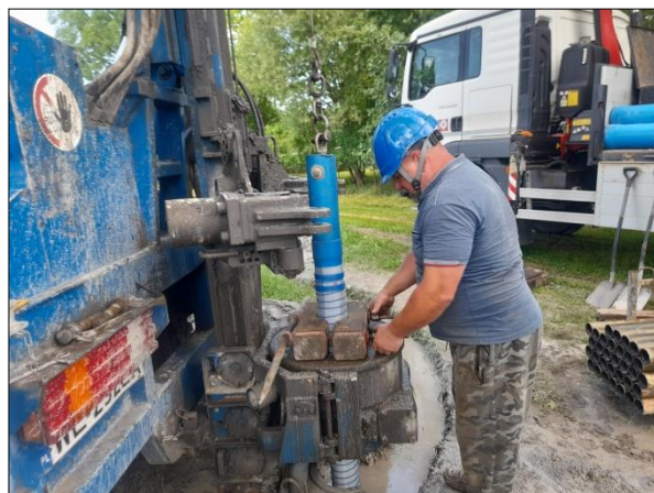
Ryc. 12.2. Filtrowanie otworu w Szczurowej, gm. Szczurowa (maj 2024 r.). Głębokość wiercenia 79,0 m.
