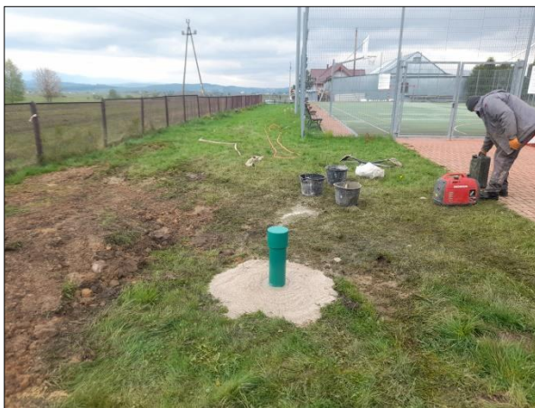
Ryc. 12.5. Zabezpieczony otwór w m. Chyżne, gm. Jabłonka (kwiecień 2024). Głębokość wiercenia 11,0 m.
