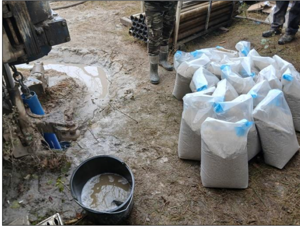
Ryc. 12.3. Przygotowanie do wykonania obsypki filtracyjnej w Nowych Jaroszwicach, gm. Bolesławiec (wrzesień 2024 r.). Głębokość wiercenia 65,0 m.
