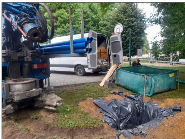
Ryc. 12.1. Przygotowanie wiertni w Kolbuszowej, gm. Kolbuszowa (czerwiec 2024 r.). Głębokość wiercenia 12,0 m.
