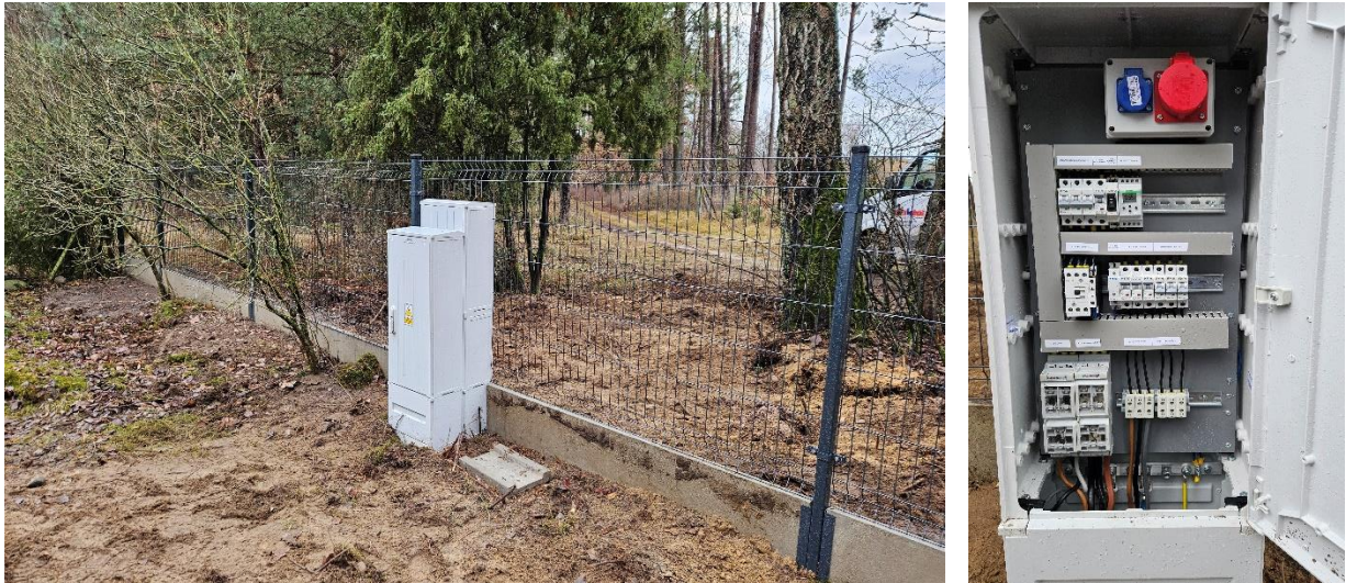
Ryc.10.6. Zmodernizowane zasilanie instalacji elektrycznej na stacji hydrogeologicznej I/257 Jagodowo (woj. kujawsko-pomorskie).
