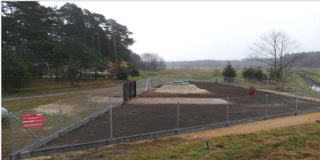
Ryc. 10.9. Stacja hydrogeologiczna II/1023 Trzebielino (woj. pomorskie) po wykonaniu prac modernizacyjnych.
