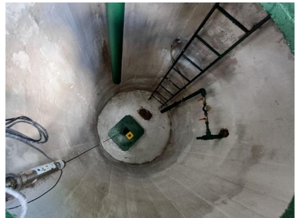
Ryc.10.4. Punkt SOBWP numer II/1084 Ewunin (woj. lubelskie) po wykonaniu prac remontowych. po prawej widoczny moduł automatyki pomiarowej.
